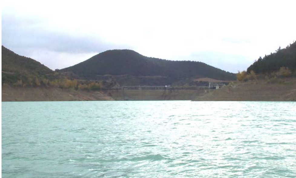
Vista de la presa desde la estación de muestreo (E1). Invierno de 2004 (09/11/2004)
