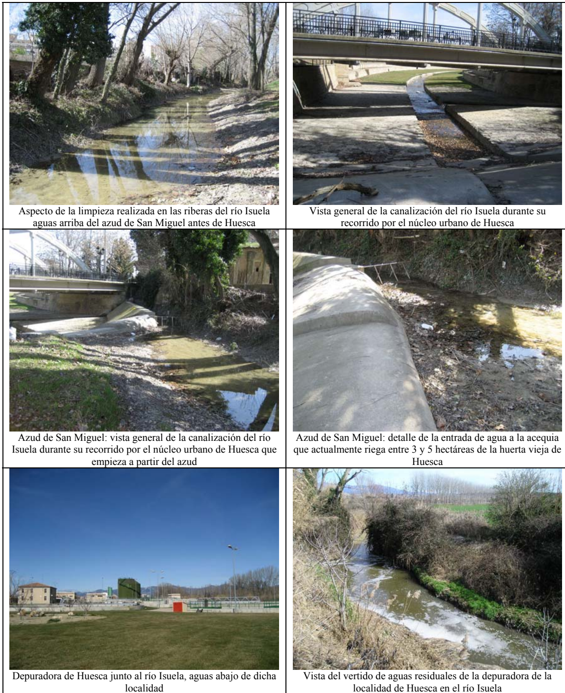
Figura 3.37 (continuación): Fotos representativas de las características y problemas del río Isuela desde el puente de Nueno hasta su desembocadura.
