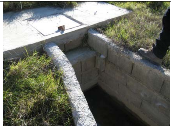
Entrada de agua del río Alcanadre para una toma de regadío del monte de Sigena situada aguas abajo de la localidad de Sena
