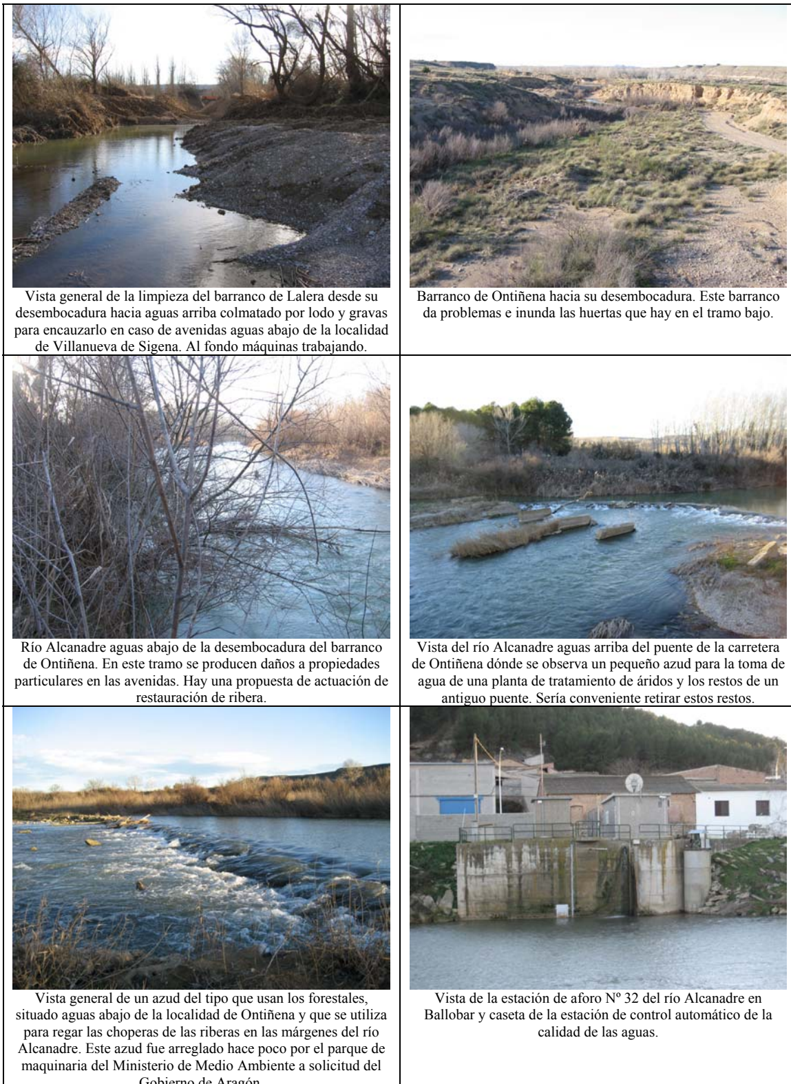
Figura 3.15 (continuación): Fotos representativas de las características y problemas del río Alcanadre desde el río Flumen hasta su desembocadura en el río Cinca.
