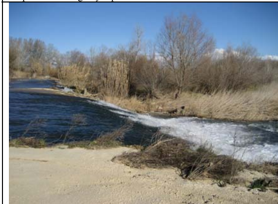
Vista del azud para la acequia que riega la huerta vieja de Ontiñena y Chalamera. Puede observarse el estado de invasión del cauce por la vegetación natural aguas abajo del azud.
