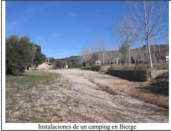
Instalaciones de un camping en Bierge
