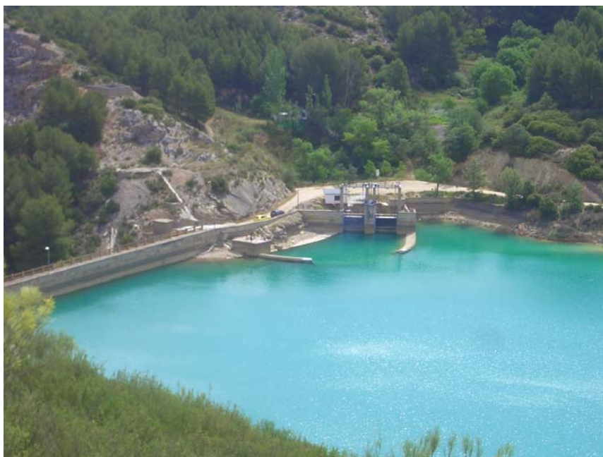
Foto 1: Presa del embalse de Las Torcas
