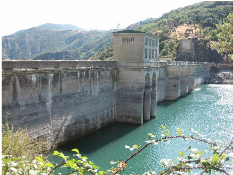
Foto 1: Presa del embalse de Mansilla
