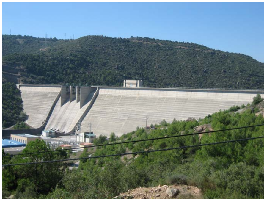
Foto 1: Vista general de la presa del embalse
