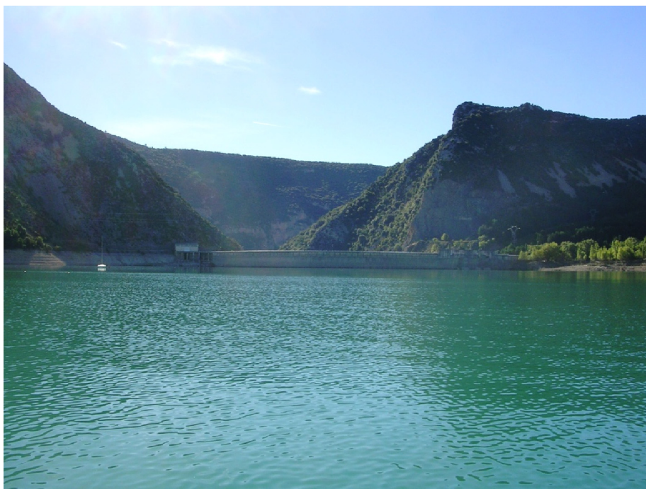
Figura 7. Vista de la presa del embalse
