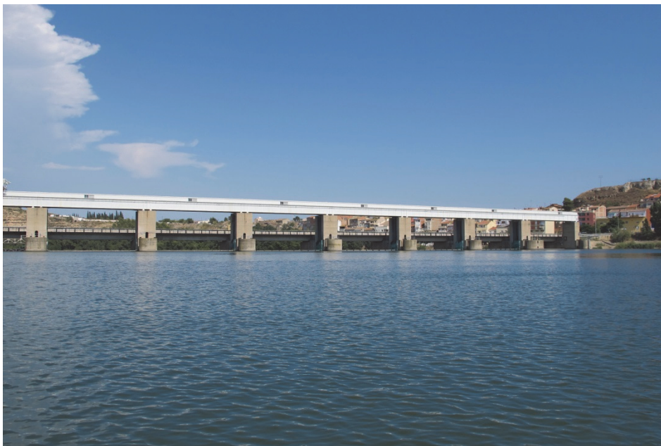
Figura 6. Vista de la presa del embalse
